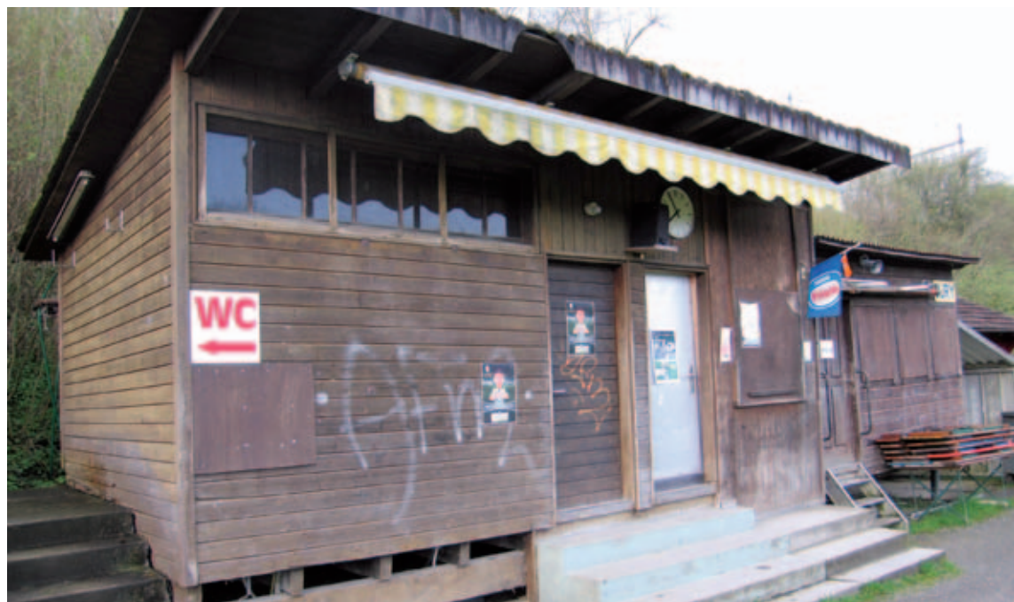
Die Baracken am Dammweg sind bereits geräumt. Sie machen einem neuen Garderobengebäude Platz.
