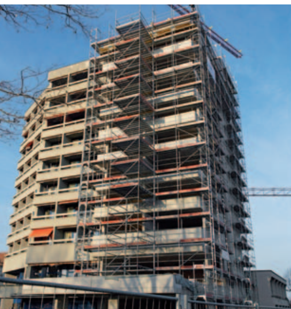
Die Bauarbeiten am «la vita» liegen im Zeitplan.
