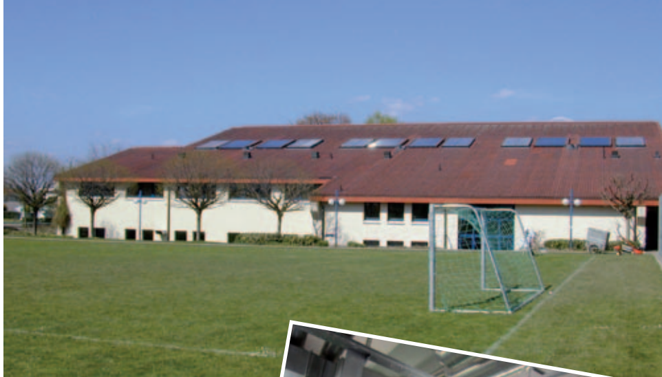
Wartegghalle: Nach 30 Betriebsjahren besteht Renovationsbedarf.
