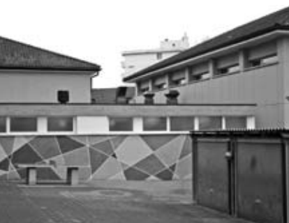
Lüftungsanlage für die Rosenacker-Turnhallen.
