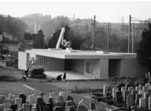
Die Bauabrechnung über die neue Aufbahrungshalle schloss im Rahmen des Voranschlages ab.
