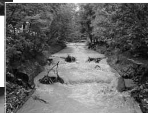
Der Nordteil der Goldach vor der Sanierung
