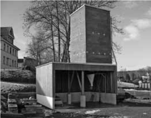
Der neue Salzsilo erleichtert dem Werkhof den Winterdienst.
