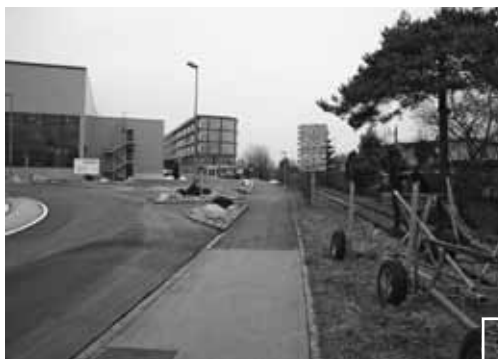
Der ausgebaute Langgrütiweg
