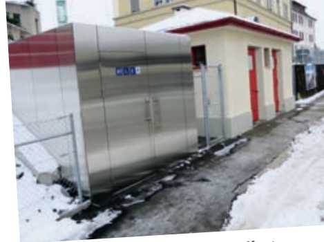
Beim Bahnhof sieht wieder ein öffentliches WC zur Verfügung, ein Gemeinschaftswerk von SBB und Gemeinde.
