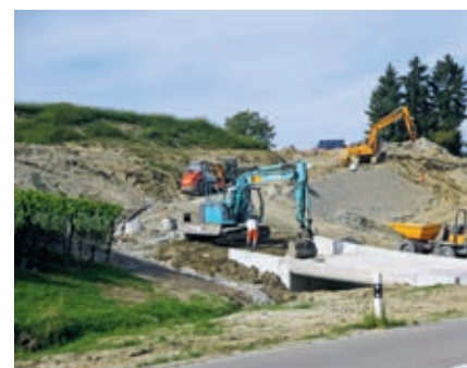
Im Frühjahr 2016 fuhren im Sonnental die Baumaschinen auf.
