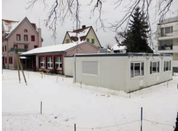
Aussen Container, innen Schulzimmer: Das Provisorium beim Kindergarten Blumenstrasse bewährt sich.
