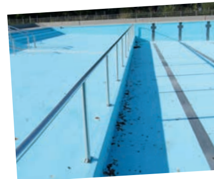
Um grösseren Schäden vorzubeugen, soll das grosse Schwimmb Becken im Freibad Seegarten mit einer Folie überzogen werden.
