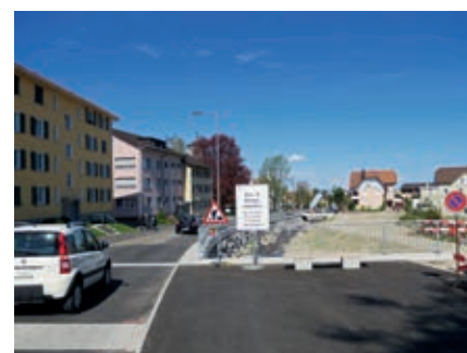
Die Bauarbeiten an der Schulstrasse sind abgeschlossen.
