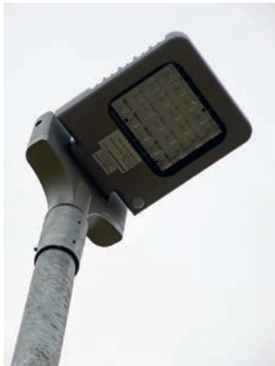
Wo immer möglich werden neue LED-Strassenlampen mit Bewegungsmeldern ausgerüstet.
