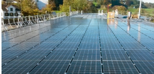
Auf dem Dach des TSM entstand eine Photovoltaikanlage.
