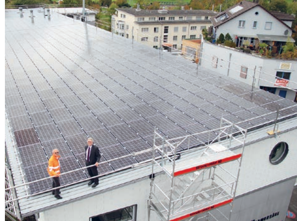
Ein neu zu schaffender Energiefonds soll mithelfen, den Bau von Photovoltaikanlagen zu fördern.
