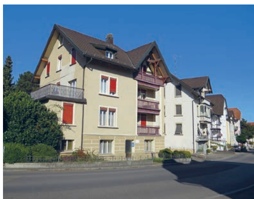
Die Wohnhäuser Blumenstrasse 47 und 49 sollen Ersatz bieten für die abgehenden Wohnungen im Schäfli-Areal
