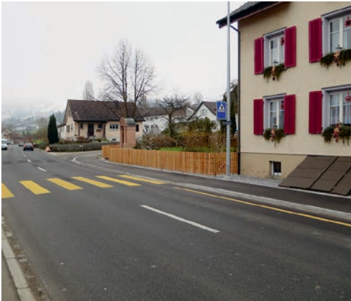
Der Kanton hat den Fussgängerübergang über die Sulzstrasse im Bereich der Tellstrasse verbessert und damit sicher gemacht.
