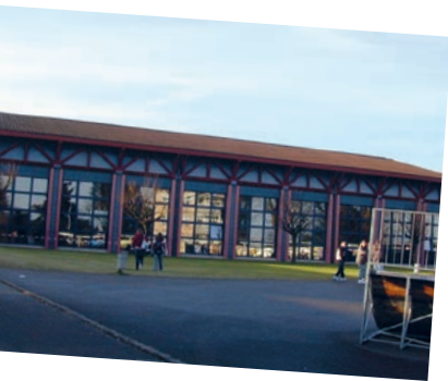
Die Wartegghalle wird von April bis Oktober 2015 saniert und ist während dieser Zeit geschlossen.
