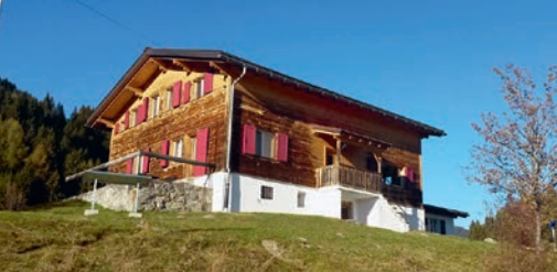
Für das Lagerhaus Gonda in Ladir besteht Sanierungsbedarf.
