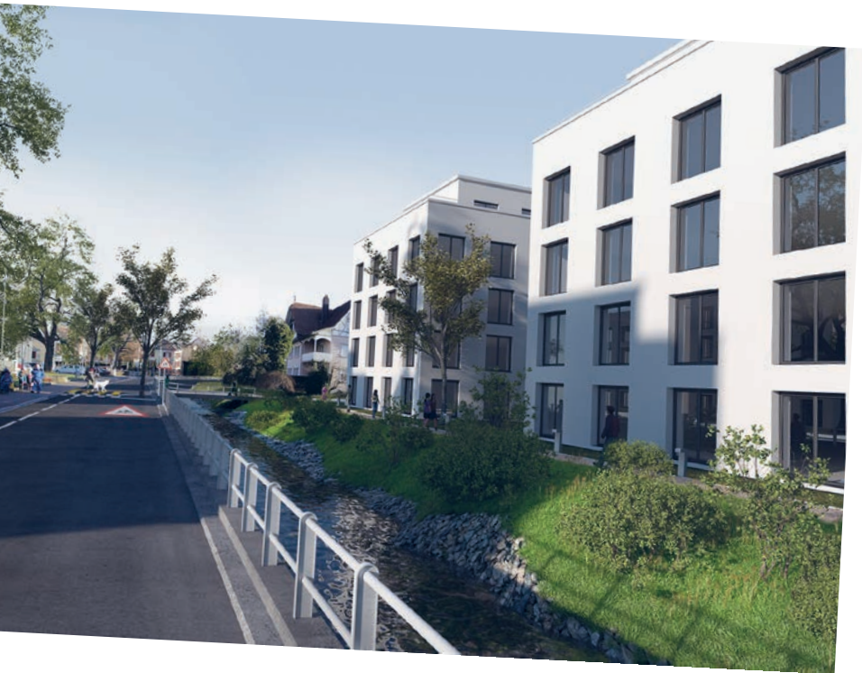
Im April 2015 starten die Bauarbeiten an der Verlegung des Dorfbaches und der Neugestaltung der Schulstrasse.
