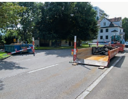
Die TBG mussten an der Florastrasse das Elektrizitätsnetz verstärken.
